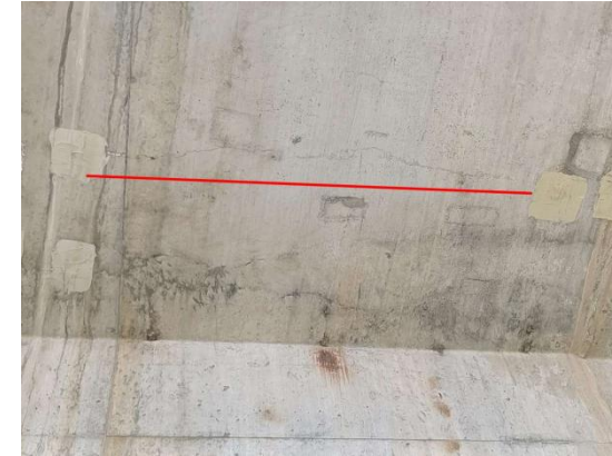
图 3-1: 桐山溪特大桥(上行) R-5-5-7 箱梁: 距 5 号墩 27m 处, 右翼缘板纵向裂缝; 长度: 2m, 宽度: 0.16mm, 数量: 1 条。
