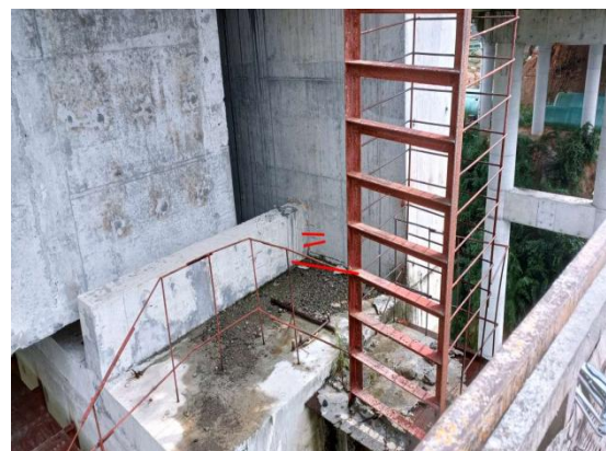
图 3-11: 桐山溪特大桥(下行) GL-L-3D 盖梁: 距左侧 0m 处, 大桩号面露筋; 数量: 3 处, 长度: 0.5m, 宽度: 0m。
